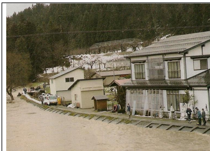
リーフレットにある皆瀬川（戸波橋上流）での増水
